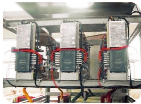
晶闸管阀组安装效果图
